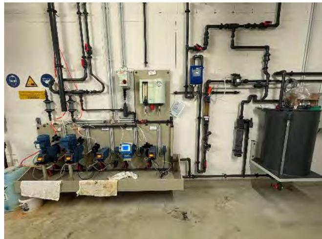
Die Dosierpumpen sowie Dosierleitungen (Schläuche und Rohre) sind **jährlich** zu prüfen und ggf. Teile auszutauschen.
