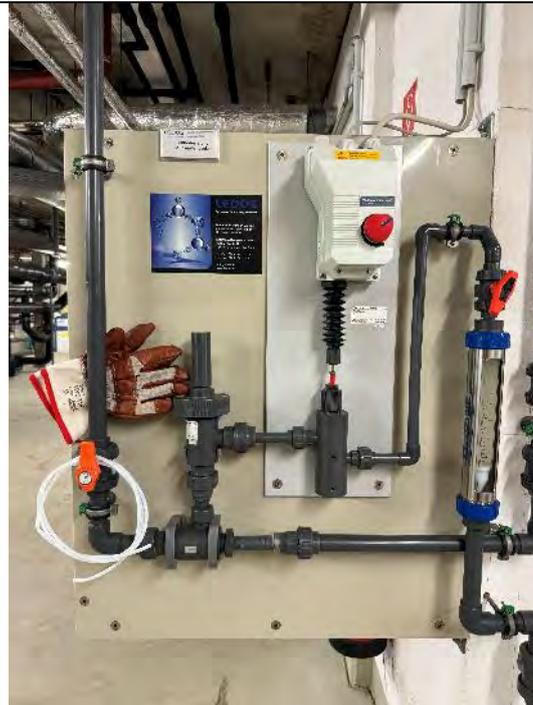
Chlorgasarmaturen sind im Rahmen der Prüfung der Chlorgasanlage mit zu prüfen und diese Tätigkeiten zu protokollieren
